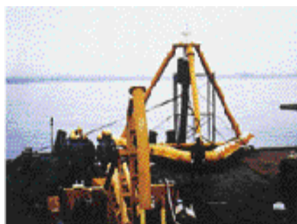
取水管の先端とそれを支えるフレーム
