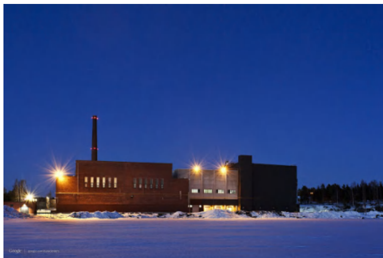
フィンランドのハミナデータセンター
